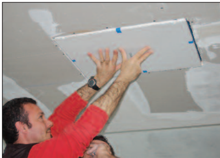
2. Montaggio del diffusore
