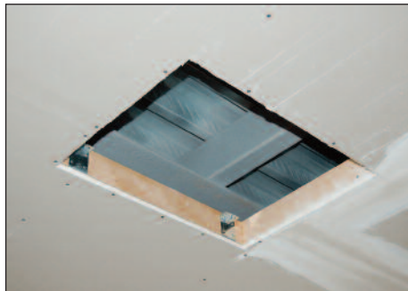
1. Fissaggio del telaio
